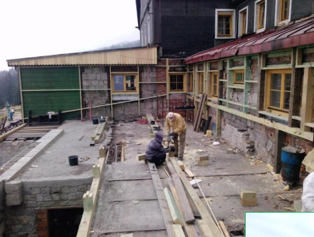
Przebudowa stropu nad wejściem głównym i termomodernizacja ściany frontowej
