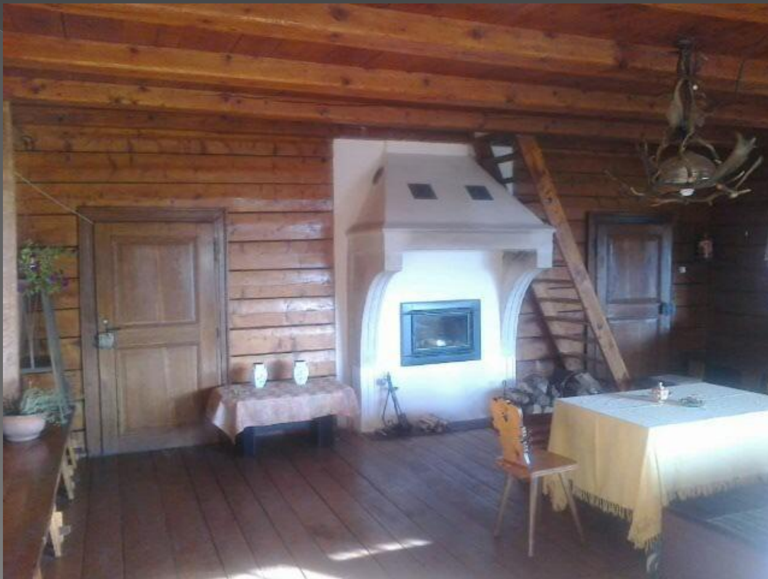
Ściana z kominem i kominkiem po rewitalizacji
