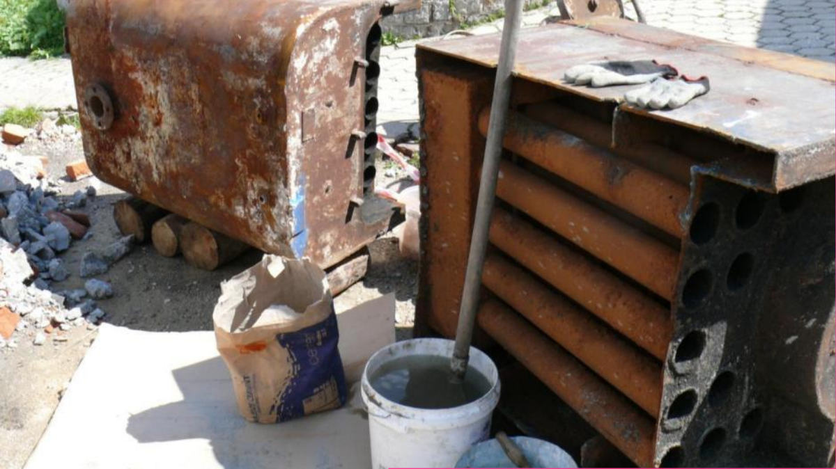
Zdemontowane stare poniemieckie kotły
