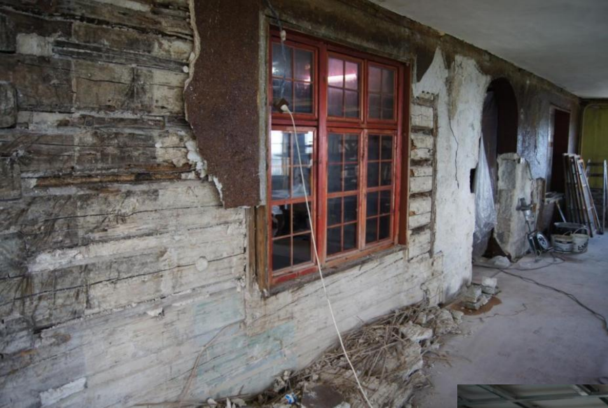
Ściana wewnętrzna sali głównej przed modernizacją
