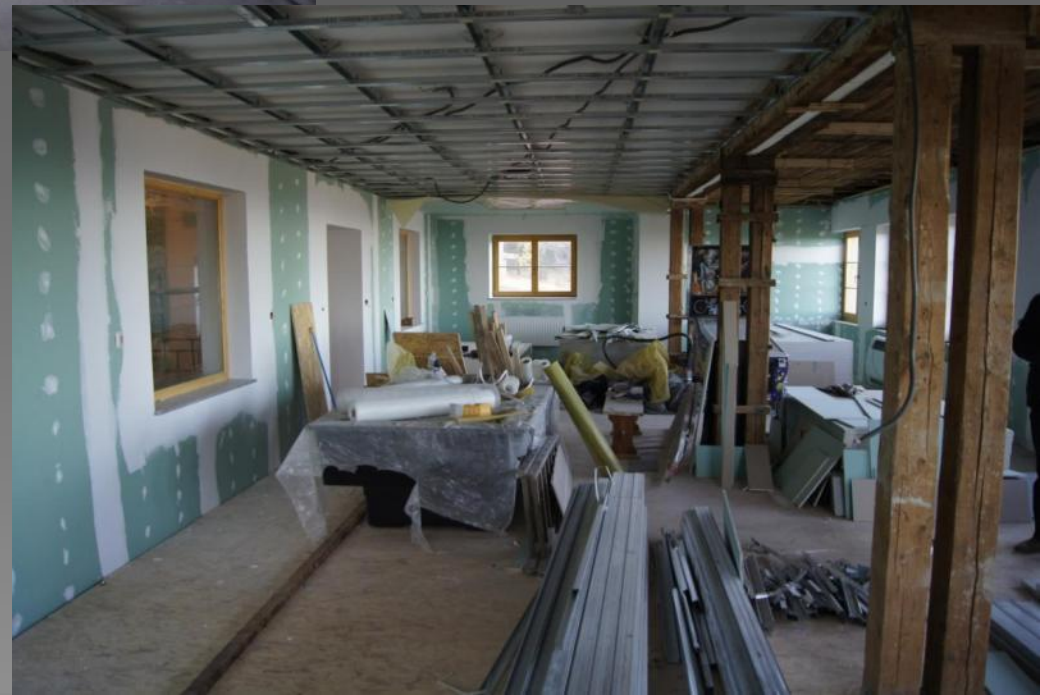
Wnętrze sali głównej w trakcie modernizacji
